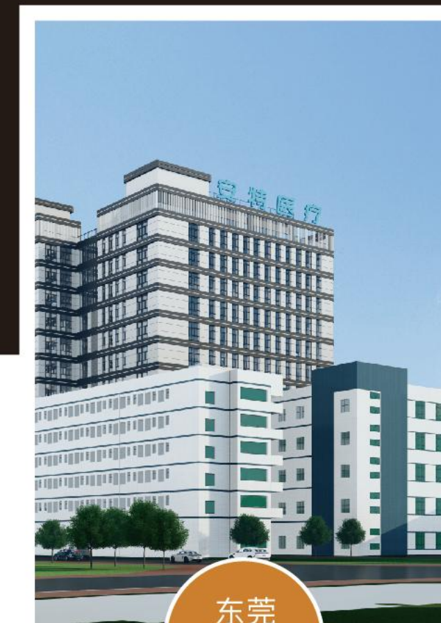
东莞 凤岗园区
